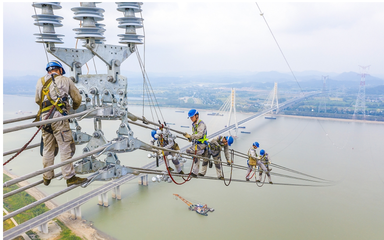
在安徽池州长江边,施工人员在三百多米高空进行跨江作业(九月十五日摄)。九月十六日,白鹤滩至浙江特高压直流输电工程安徽段顺利完工,完成长江大跨越放线作业。十年来,我国交通、能源、水利和新型基础设施发展取得了历史性成就,现代综合立体交通运输体系、现代能源体系加快构建,基础设施整体水平实现跨越式提升。
