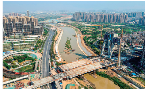
中秋假期期间,引江济淮工程江淮沟通段各项目建设工地的施工人员坚守岗位,确保工程进展顺利。新华社记者刘军喜摄
