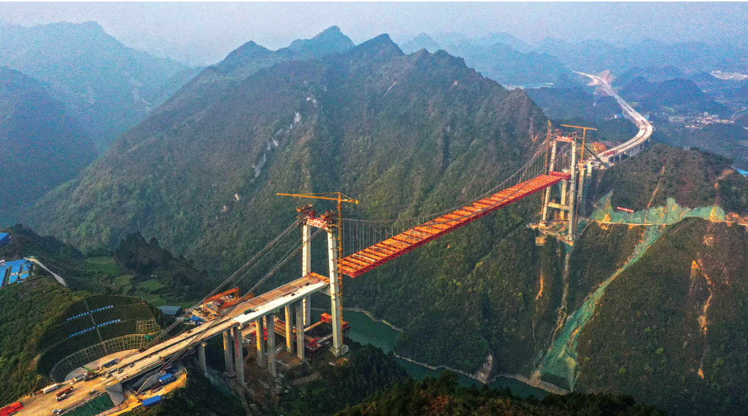
这是3月18日拍摄的贵州省贵黄高速公路阳宝山特大桥,目前工程已进入钢桁梁吊装收尾阶段。阳宝山特大桥位于贵州省黔南布依族苗族自治州贵定县新巴镇和德新镇境内,大桥全长1112米,主跨650米,是贵黄高速公路控制性工程。
