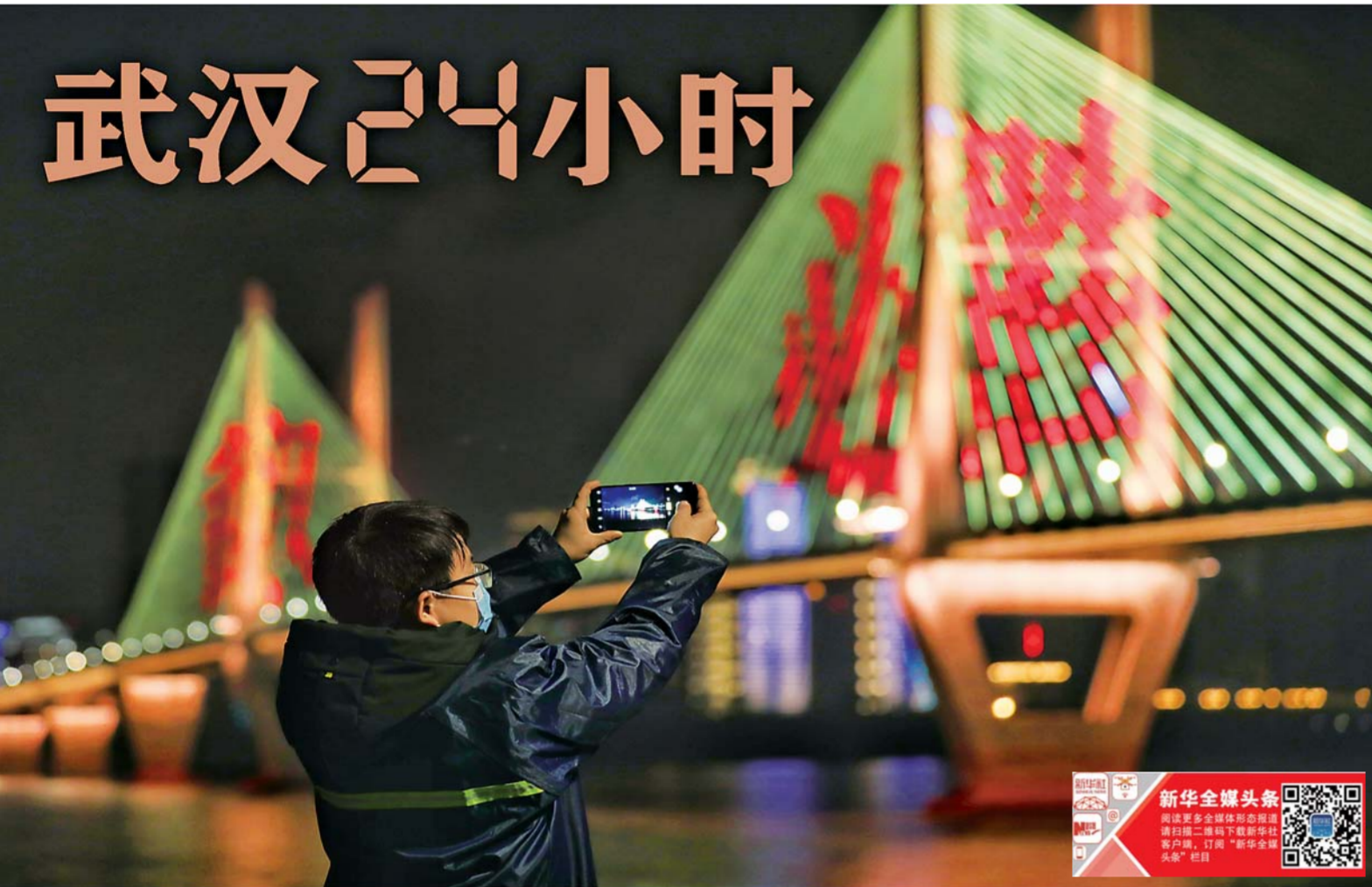
▲2月28日,灯光维修师温瑞在雨夜中拍照记录武汉长江二桥灯光情况。
