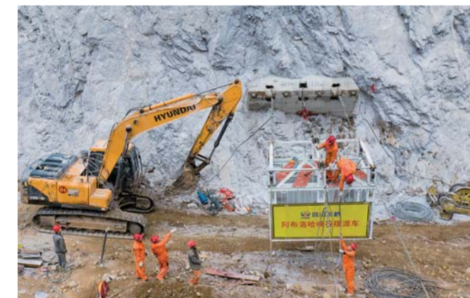
▲四川路桥的施工队伍在对阿布洛哈村摆渡车进行最后的安装和调试(2019年12月27日摄)。
