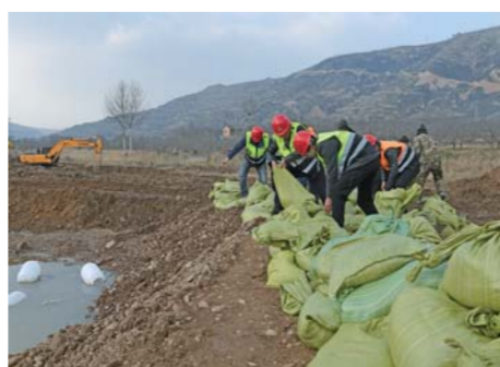
▲11月27日,在天水市秦安县莲花镇上河村6号围堰位置,当地政府组织人员加固围堰体。新华社记者范培坤摄
