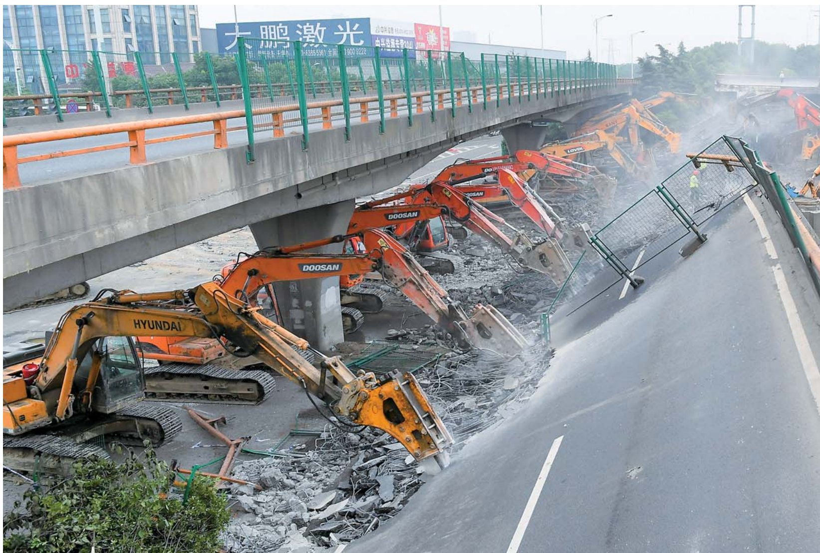
▲ 10月11日，在江苏无锡高架桥侧翻事故现场，施工机械在破拆侧翻高架桥段。 新华社记者李博摄
