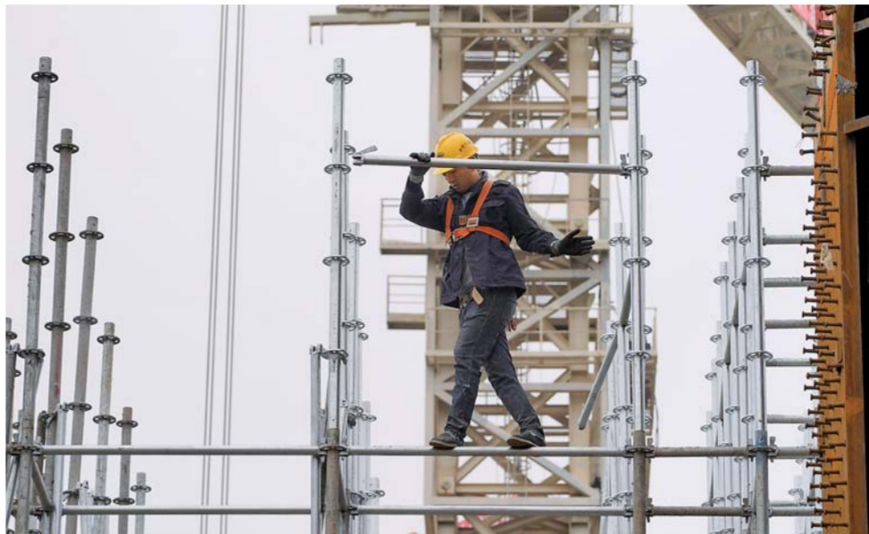
▲10月10日,中铁十二局的工人在雄安站施工。京雄城际铁路雄安站总建筑面积约47万平方米,地上3层,地下2层。目前,地下主体结构基本完工,地上主体结构施工已经开始。新华社记者邢广利摄
