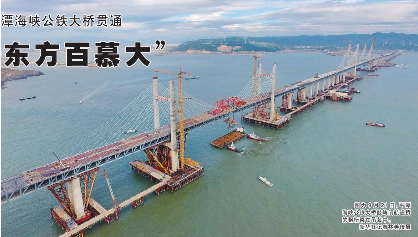
图为9月21日，平潭海峡公铁大桥鼓屿门航道桥的钢桁梁在吊装中。
