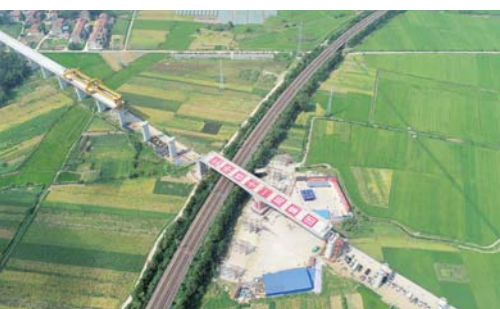
安九高铁长江特大桥跨京九段成功转体
