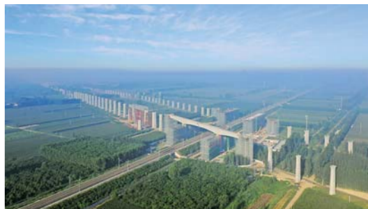
京雄城际跨津保铁路桥梁转体完成
