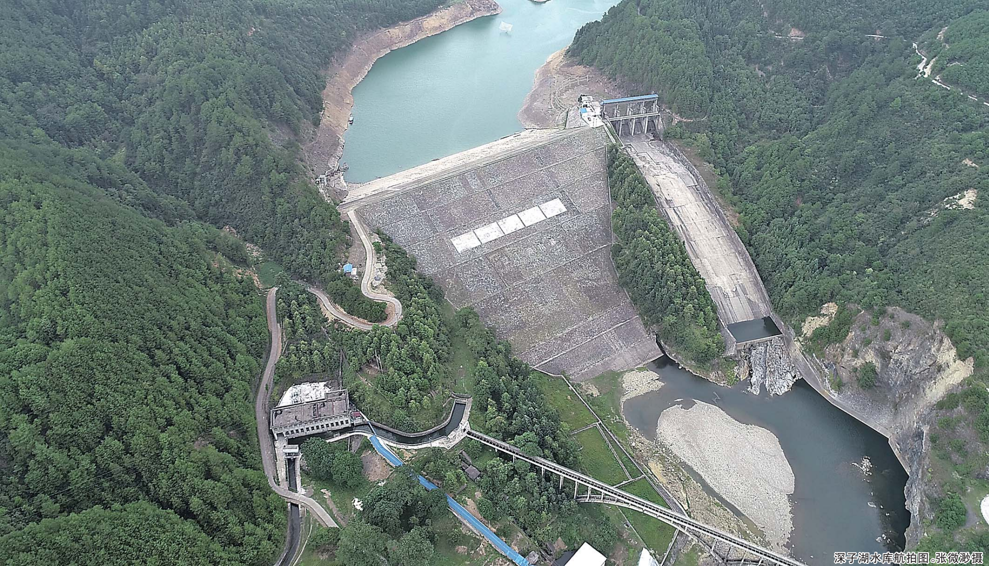
深子湖水库航拍图。张微秒摄
