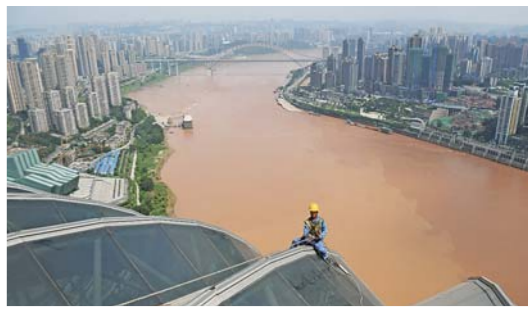
高温下的建设者
