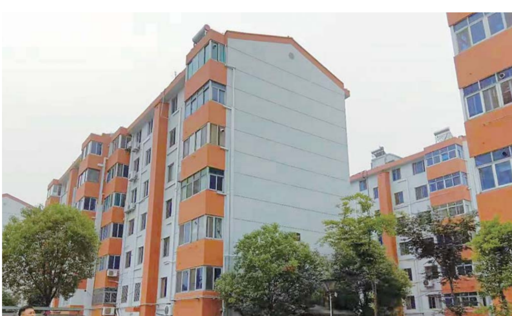
上图：江山小区改造前的屋顶。受访者供图
