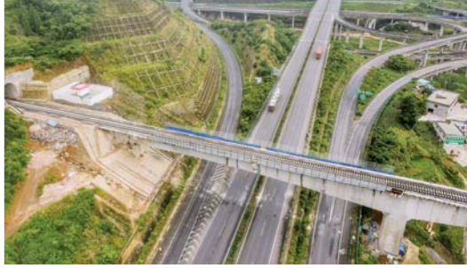
贵州首条自建自营铁路铺轨完成
