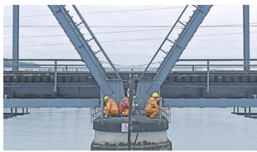
涪江铁路大桥“体检”
