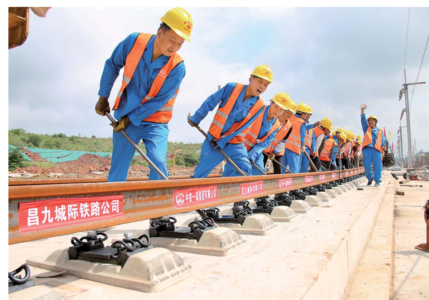
▲6月3日,工作人员在赣州西站铺设最后一对500米长轨。
