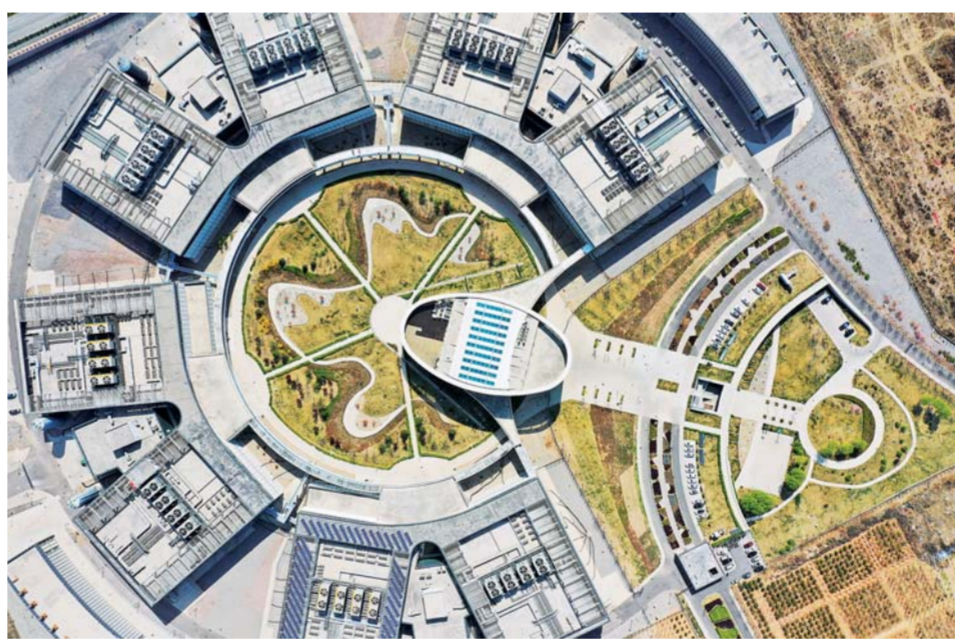
▲4月16日拍摄的位于阳泉经济开发区的百度阳泉云计算中心。新华社记者杨晨光摄
