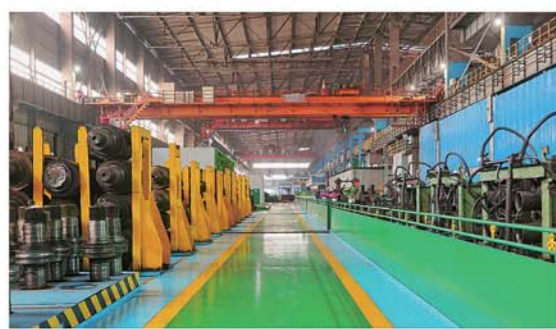
方大特钢高线准备作业现场
