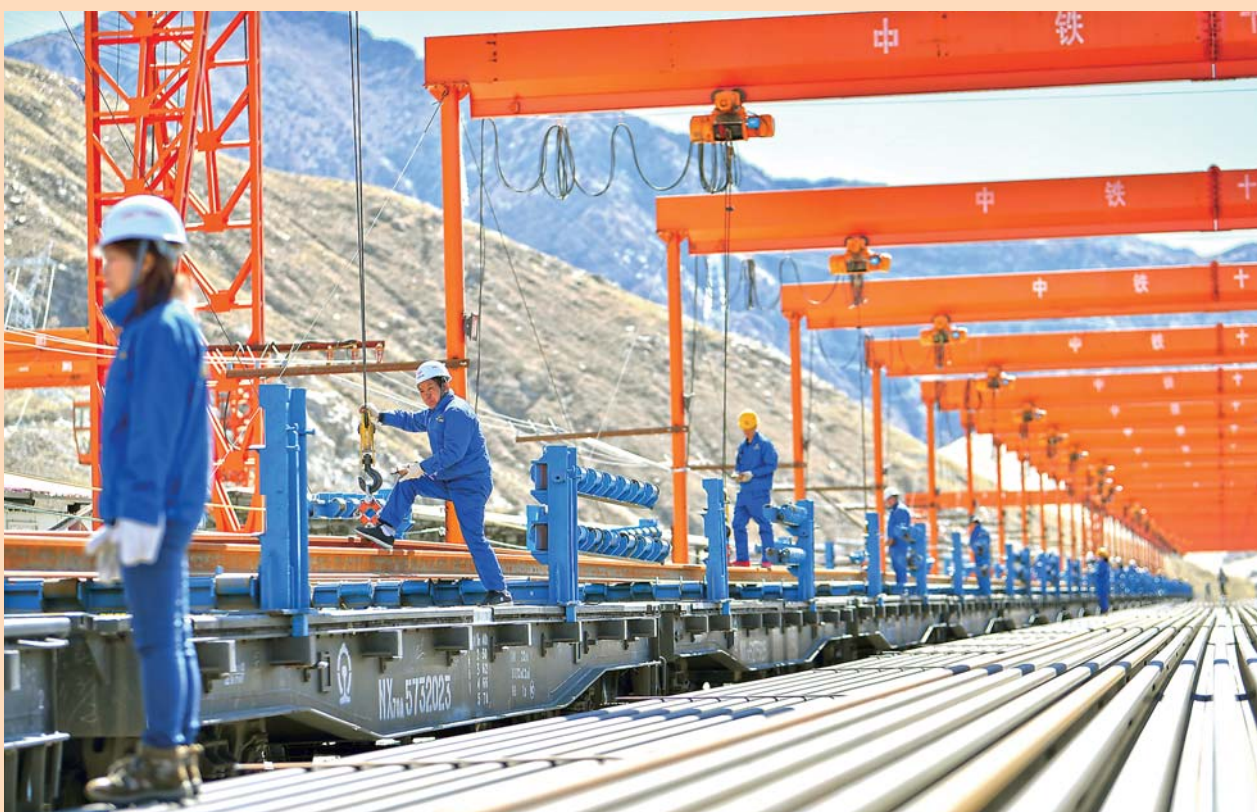
▲ 3月7日，由中铁十一局承担建设的拉林铁路曲水铺架基地长钢轨存放场，工人将钢轨吊装至钢轨推送车上。据了解，此次吊装的长钢轨即将铺设到香嘎山隧道，这也标志着拉林铁路掀起2019年铺架的序幕。新华社记者李鑫摄
