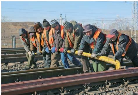
▲中国铁路太原局集团有限公司秦皇岛西工务段职工正在将备用钢轨推运到更换地点,为更换重伤钢轨做准备。近日,为确保春运期间设备安全稳定,该段利用“天窗修”“要点修”组织职工对管内线路设备进行综合整治,重点对重伤钢轨、道岔和曲线等关键处所进行整治。何乃铨摄
