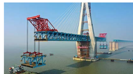
沪通长江大桥：钢梁悬吊
