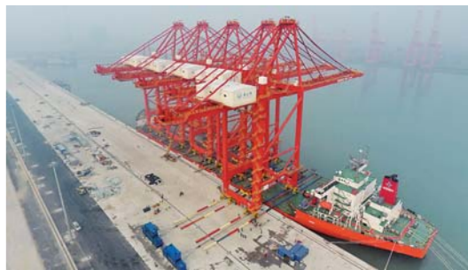
唐山港开始安装岸桥
