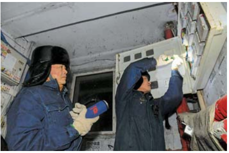
▲ 2018年12月31日,在吉林市昌邑区,吉林供电公司抢修班工人李岩(右)、张国权抢修一幢居民楼内的用电开关。
