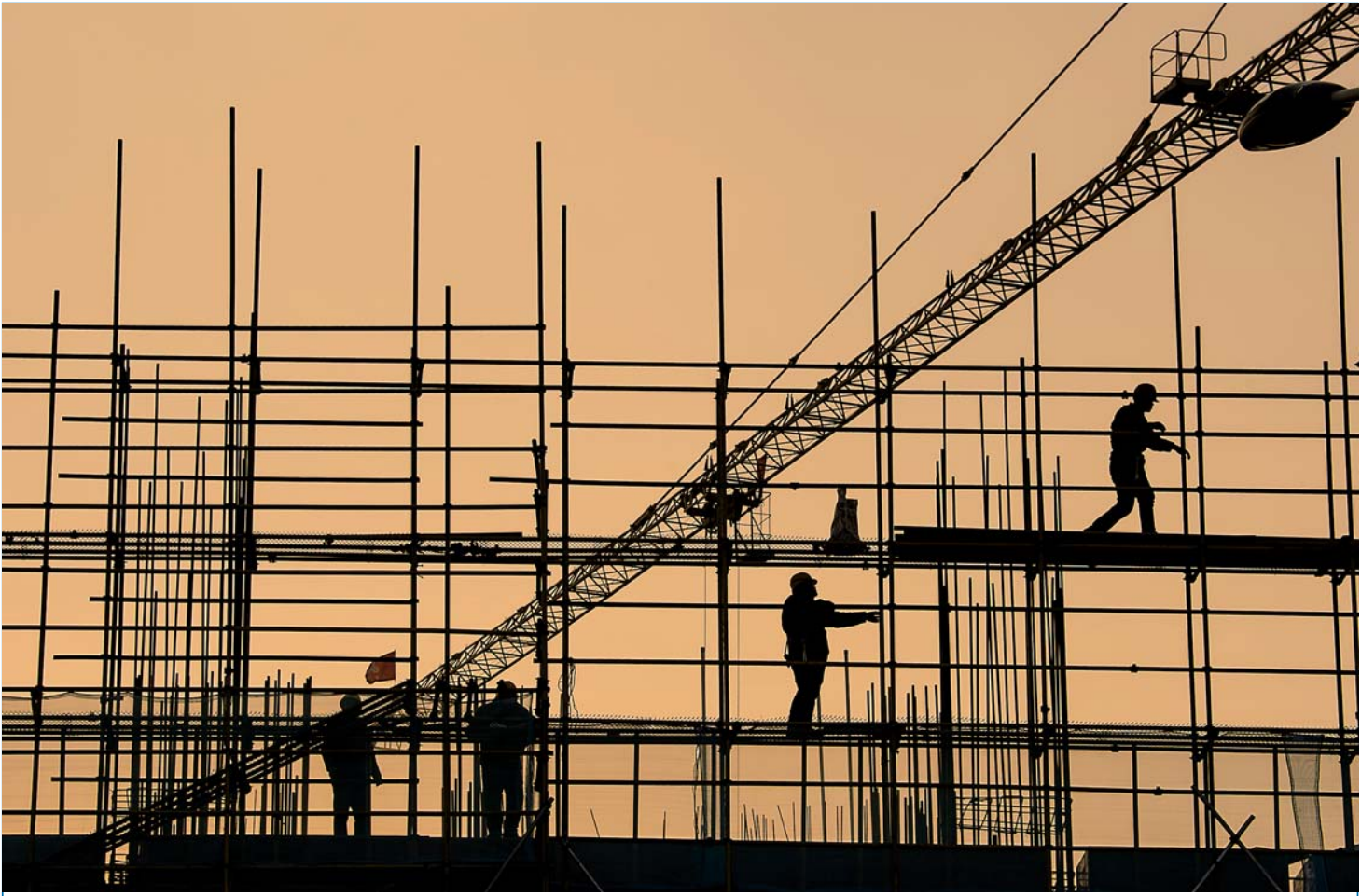
▲ 2019年1月1日,在江苏省海安市一建筑工地,工人在脚手架上作业。当日是新年第一天,众多劳动者忙碌在工作岗位上。 新华社发(徐劲拍摄)
