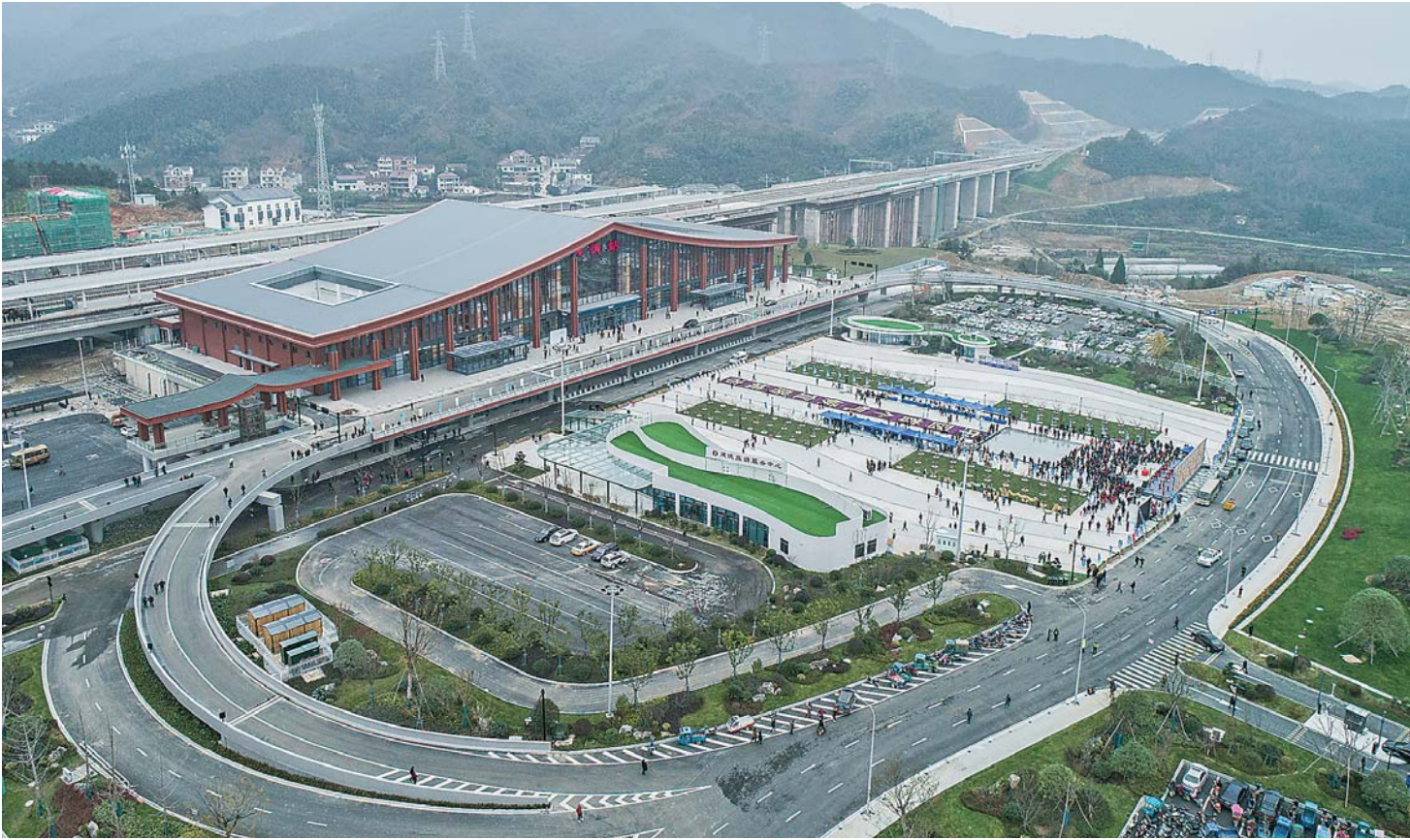
▲空中俯瞰杭黄高铁建德站(12月25日无人机拍摄)。新华社记者徐昱摄
