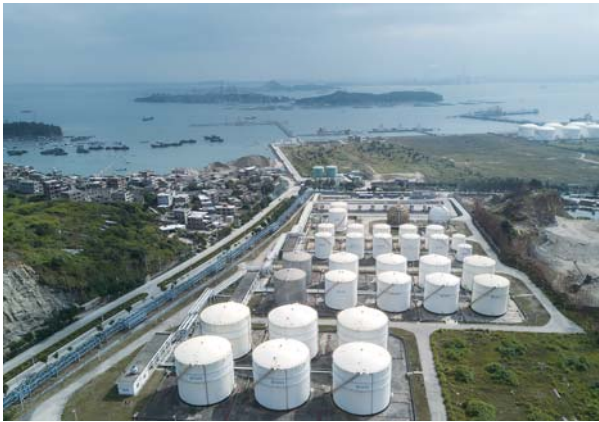
▲这是泉港裂解碳九泄漏事故涉事企业东港石化公司厂区，远处为事发码头（11月6日无人机拍摄）。 新华社记者宋为伟摄
