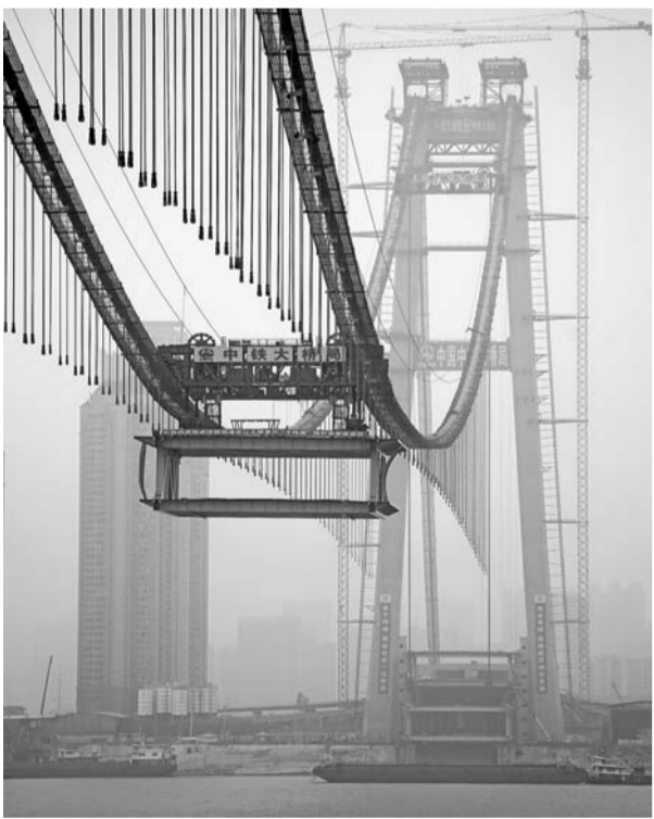
▲ 11 月 15 日, 1000 吨重的钢梁吊装到位。
