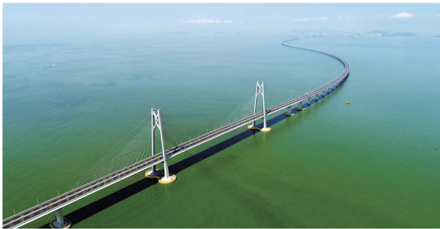
▲2018年7月11日无人机拍摄的港珠澳大桥。新华社记者梁旭摄
