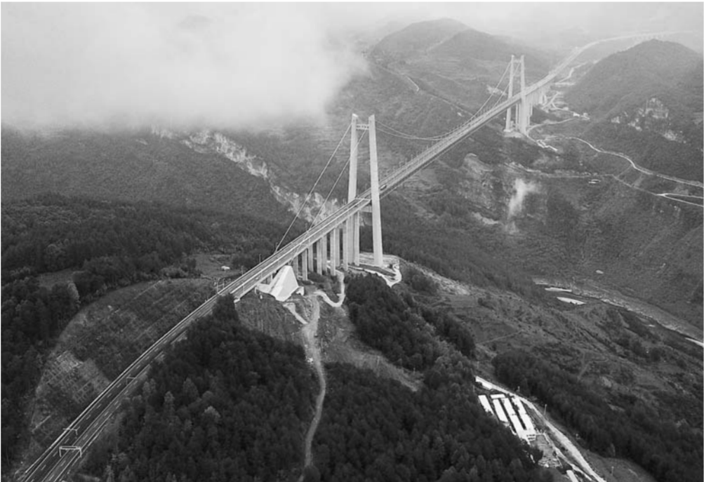
▲贵阳至瓮安高速公路上的清水河大桥（8月27日无人机拍摄）。该桥主跨1130米，是世界上最大单跨板桁结合加劲梁悬索桥。 新华社记者刘续摄
