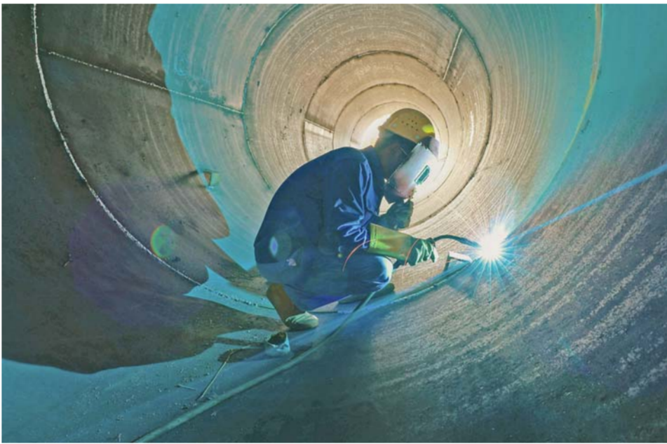
▲10月1日，江苏省淮安市盱眙县淮河大桥的建设者在施工现场作业。 新华社发(周海军摄)
