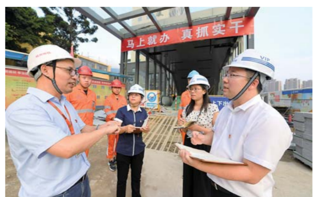
▲9月5日，福州市委组织部一线考核工作组在福州地铁2号线施工现场了解项目进展。新华社记者林善摄
