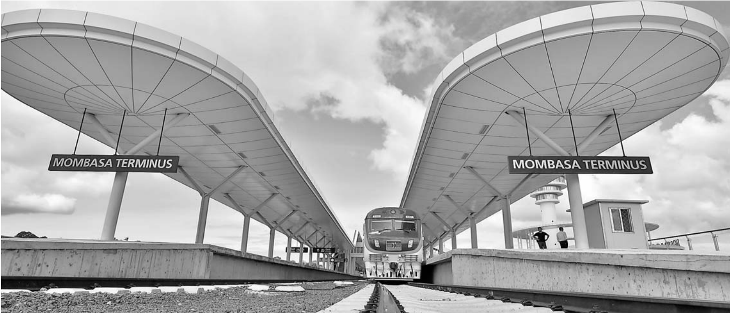
▲这是2018年6月1日拍摄的列车停靠在肯尼亚蒙内铁路蒙巴萨站。由中国承建的蒙巴萨—内罗毕标轨铁路(蒙内铁路)全长约480公里,于2017年5月通车。
