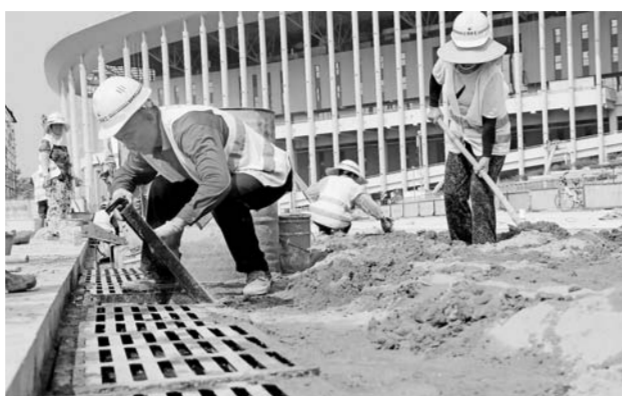
▲7月26日,工人在国家会展中心南广场外工地上铺设排水槽。 新华社记者方洁摄
