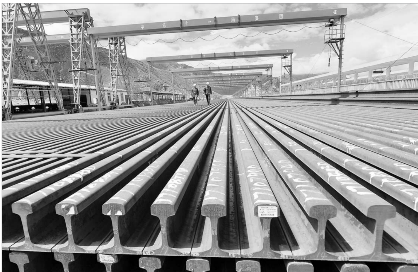
拉萨至林芝铁路 全线铺轨在即
