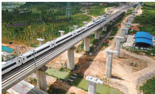
贵阳推进市域快铁建设
