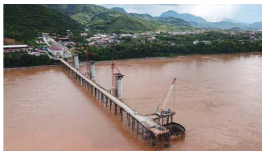
中老铁路跨越湄公河
