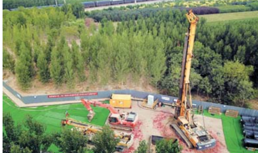
京雄城际铁路霸州段正式施工
