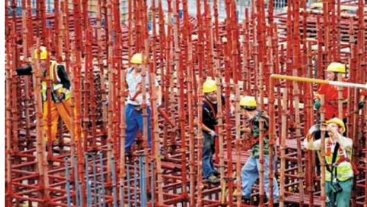
郑州南站地铁工程加紧施工
