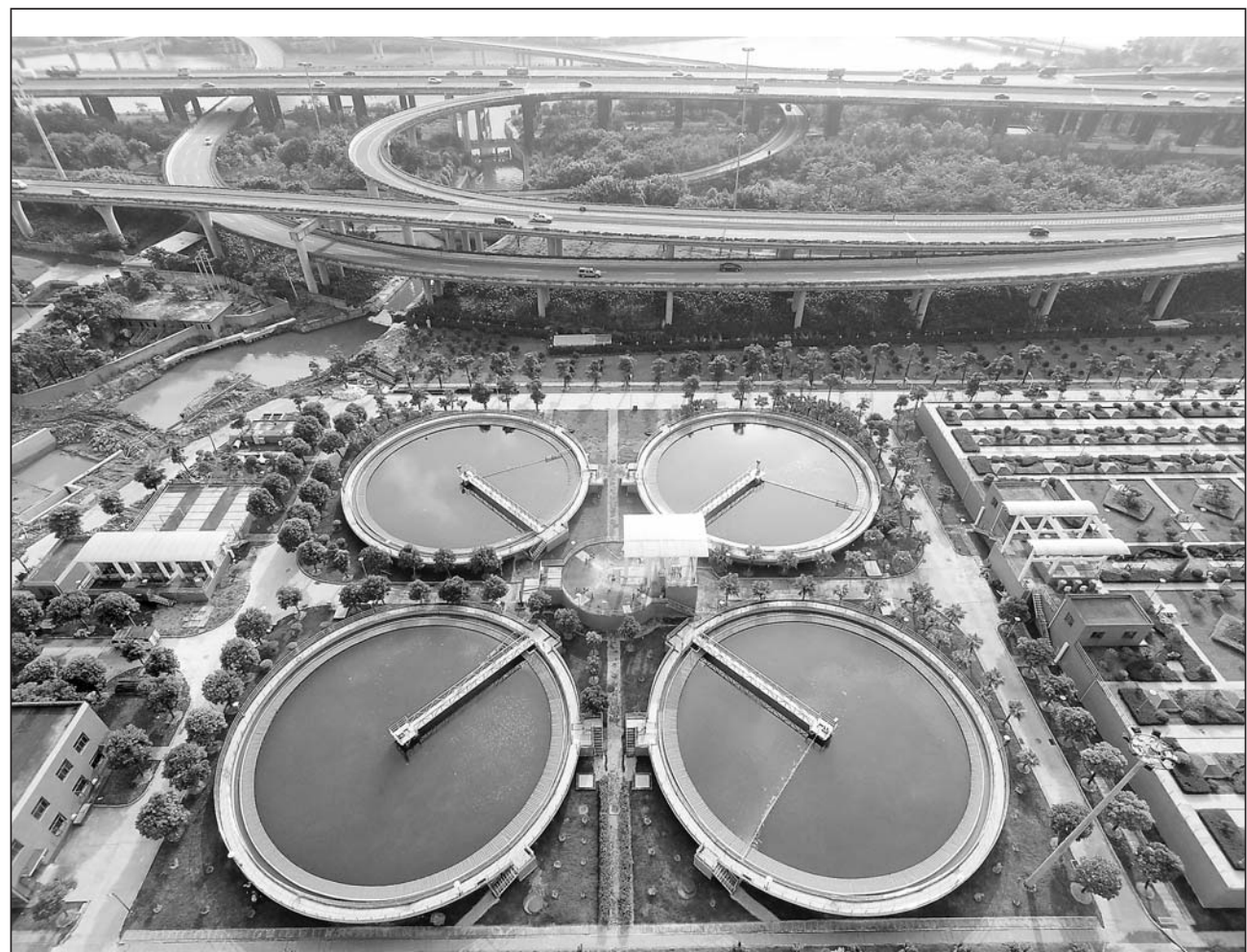
福州洋里污水处理厂三期二期沉淀池和顶层绿化的生物反应池(7月2日无人机拍摄)。近日，由中铁上海工程局集团承建的福州洋里污水处理厂一二三期提标改造工程完成土建和设备安装，进入通水试运行阶段。本次提标改造工程进一步提高污水处理标准，实现出水一级A达标排放。洋里污水处理厂位于福州鼓山南麓，担负着76平方公里、150万人口的污水处理任务，日处理污水60万吨。 新华社记者姜克摄
