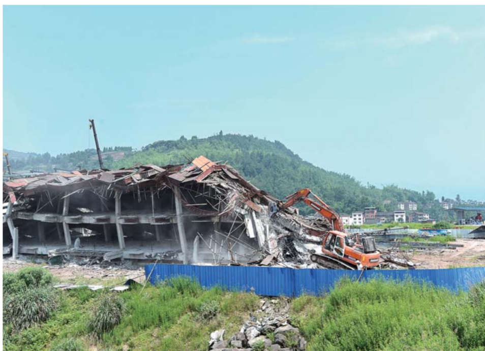
▲在重庆石柱县水磨溪湿地自然保护区，工程机械在对一家工业企业建筑进行拆除作业(6月7日摄)。新华社记者唐奕摄
