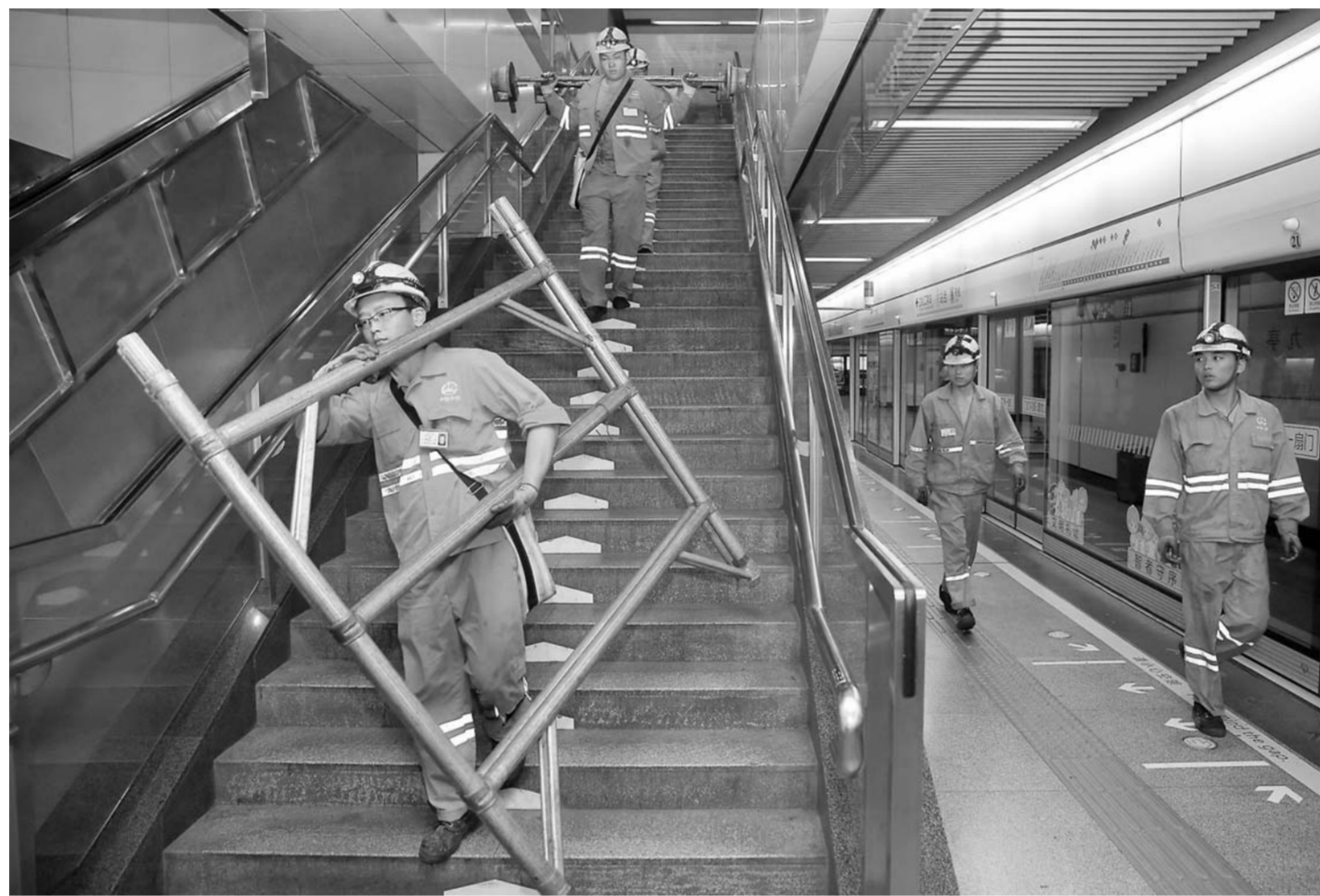
▲6月5日，在上海地铁9号线九亭站内，中铁电气化局集团上海电气化工程分公司施工人员进行作业前的准备。新华社记者丁汀摄
