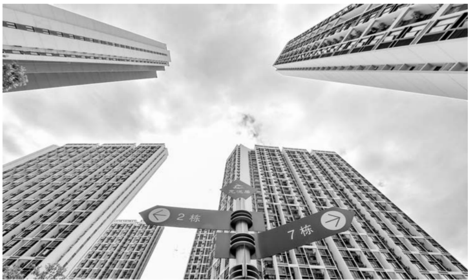
▲这是6月4日在深圳市龙华区拍摄的保障性住房项目悦居。新华社记者毛思倩摄
