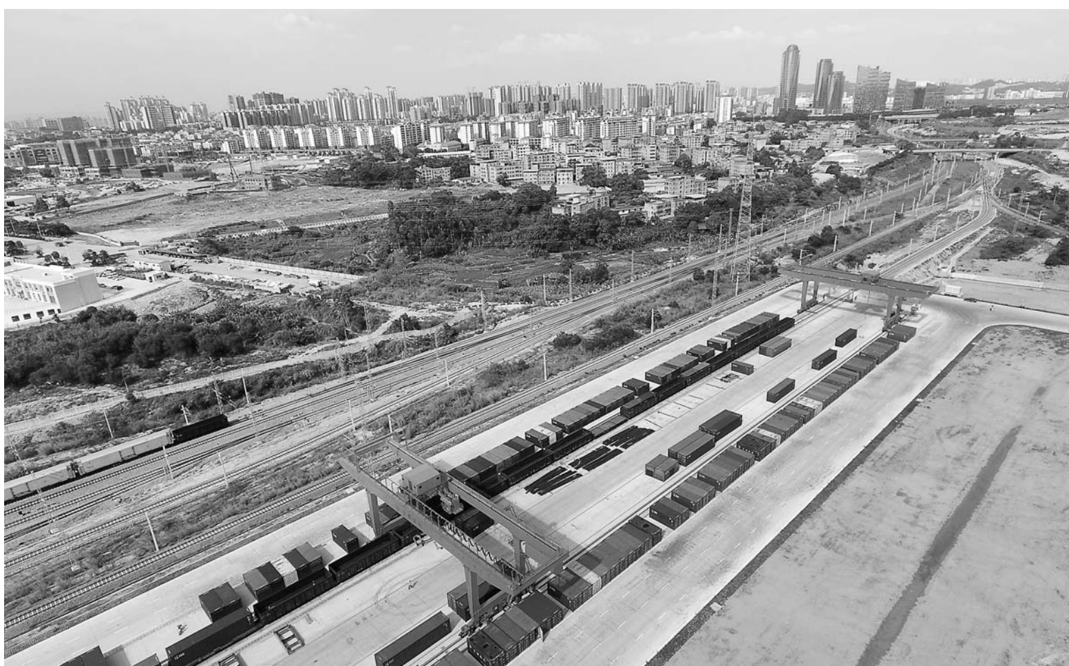
►这是正在作业中的南京铁路物流中心(5月23日无人机拍摄)。
