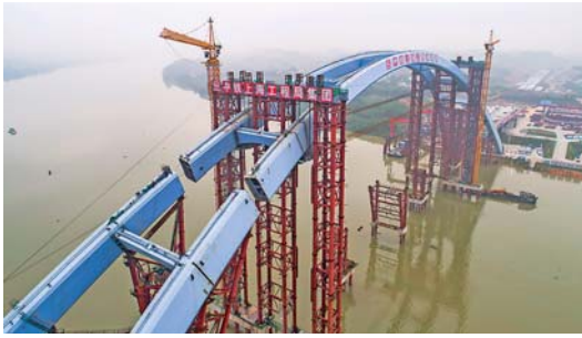
官塘大桥中拱段整体提升到位 5月14日,广西柳州官塘大桥的5885吨中拱段整体提升到位。柳州官塘大桥跨度达457米,大桥一跨过江,水中不设桥墩。 新华社发(李斌摄)
