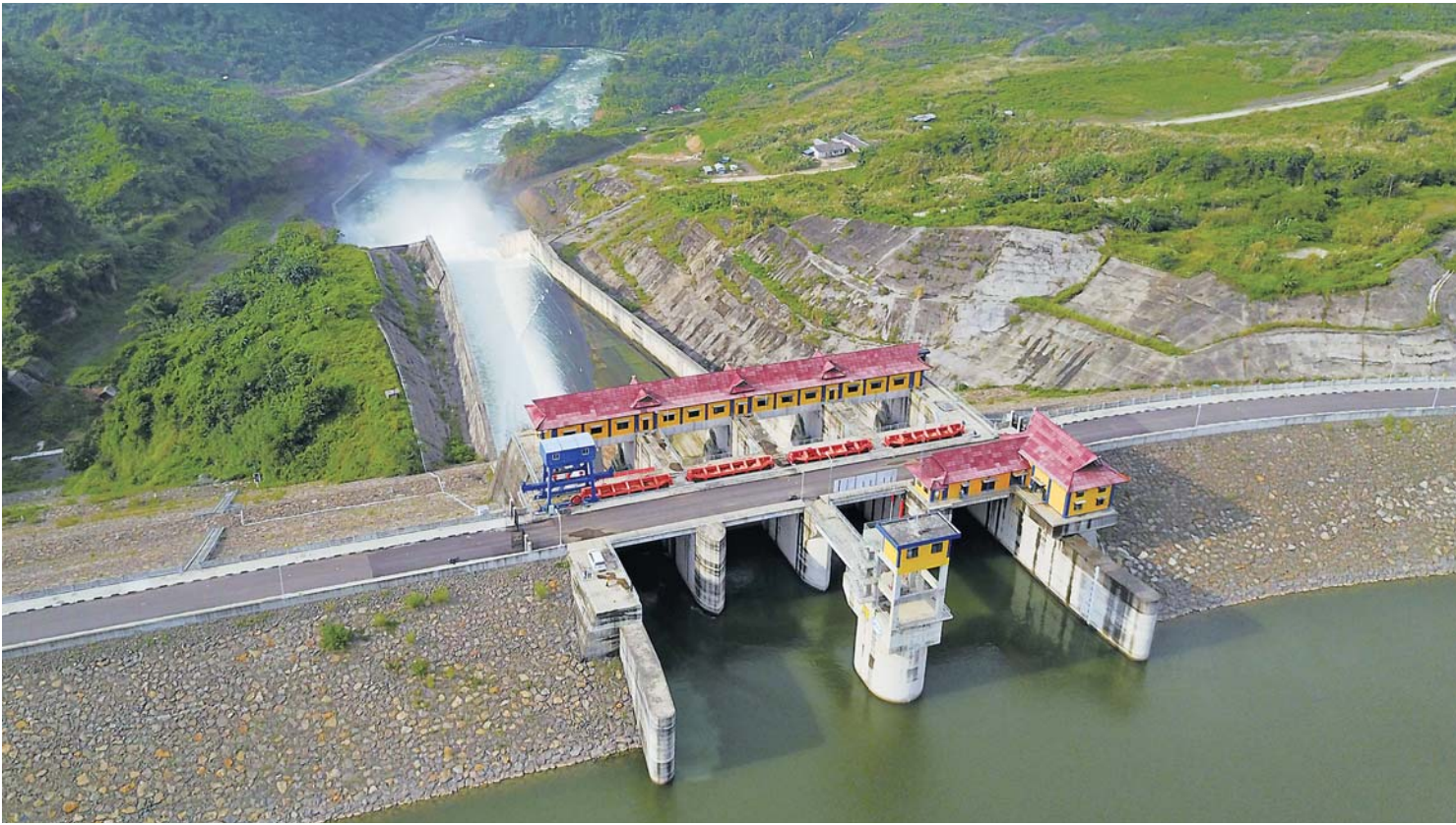
▲这是2017年3月23日在印尼西爪哇地区拍摄的加蒂格迪大坝泄洪闸口。
