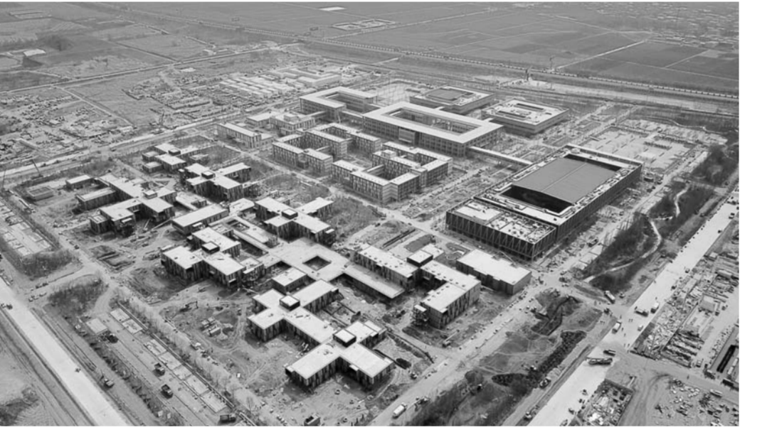
▲3月30日无人机拍摄的建设中的雄安市民服务中心。新华社记者申宏摄
