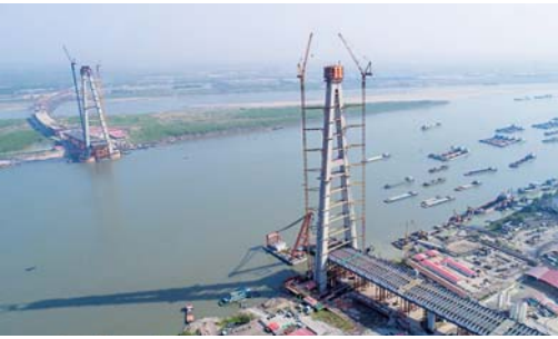
4月10日，武汉青山长江大桥南岸主塔封顶。此次封顶的南岸主塔高271.5米，相当于约100层楼房的高度，是目前已建在建的世界最高A型桥塔。 新华社记者肖艺九摄
