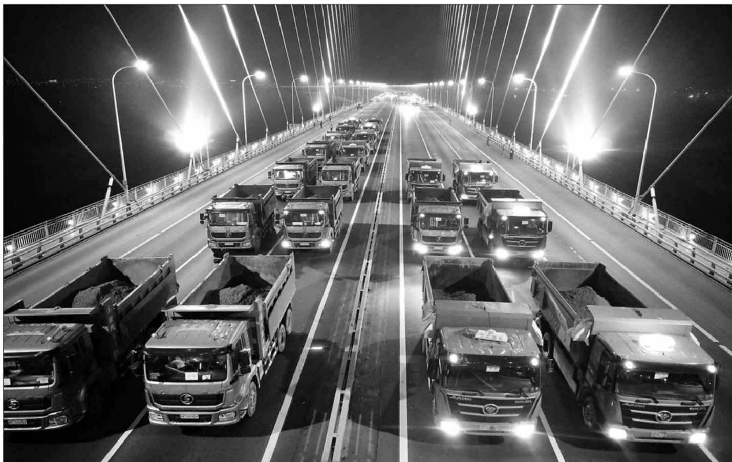
苏通大桥通车10年 首次全封闭“体检”完成
