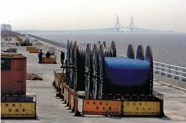
2005 洋山深水港电缆工程
