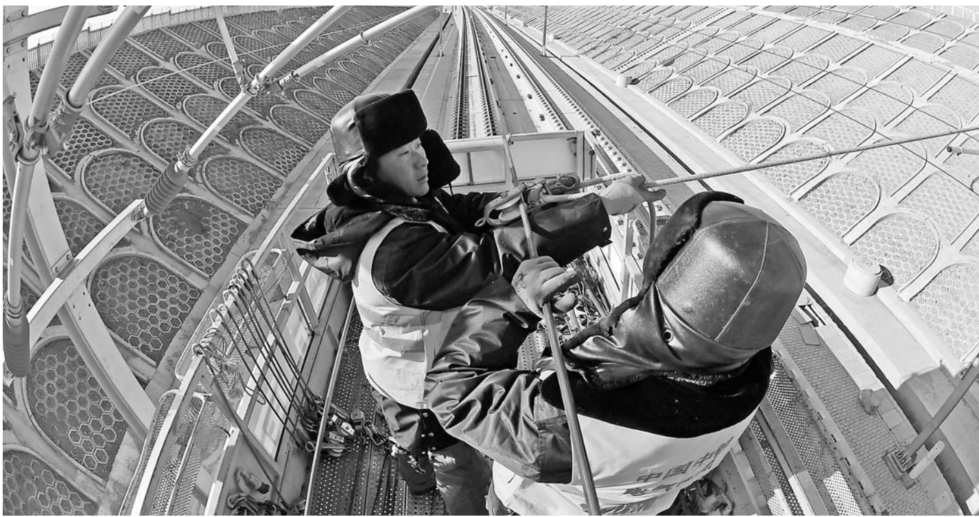
京沈高铁辽宁段接触网架设完成
