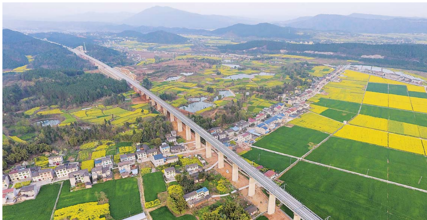
▲这是3月30日在四川江油市拍摄的西成高铁四川段一座铁路桥。
