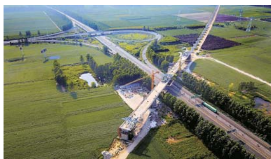
郑阜高铁先开段主体工程即将完工
